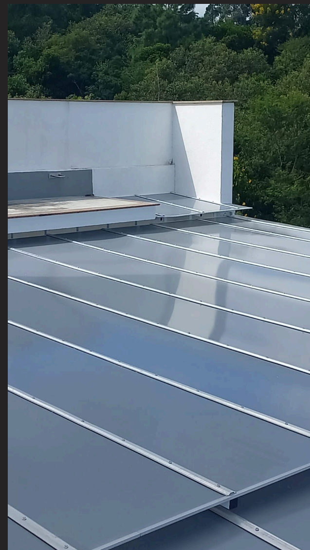
Cobertura pronta: a chapa de cima sobreposta à de baixo na emenda, apoiada na travessa.
